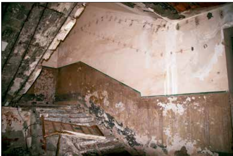
Τμήμα του κλιμακοστασίου στις Βασιλικές Τεχνικές Σχολές, 2018
